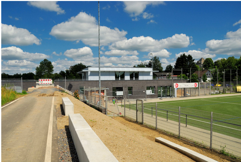
Abbildung 25: Basisstation im Bereich Ohler Wiesen Quelle: Hansestadt Wipperfürth
