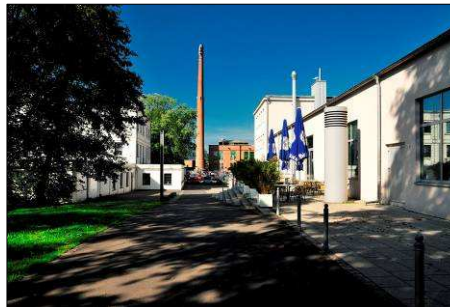
Abbildung 13: Veranstaltungshalle Alte Drahtzieherei
